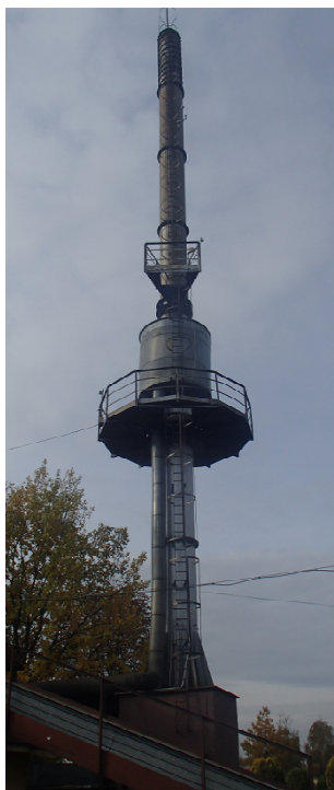
Rys. 1. Komin przeznaczony do rozbiórki
