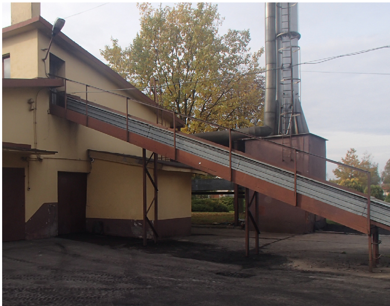
Rys.2. Taśmociąg i komin przeznaczone do demontażu.
