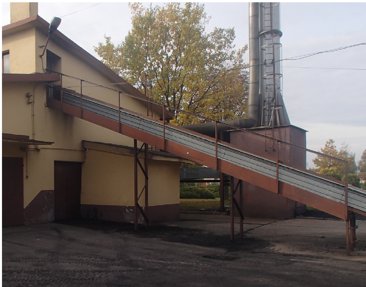
Rys.2. Taśmociąg i komin przeznaczone do demontażu.
