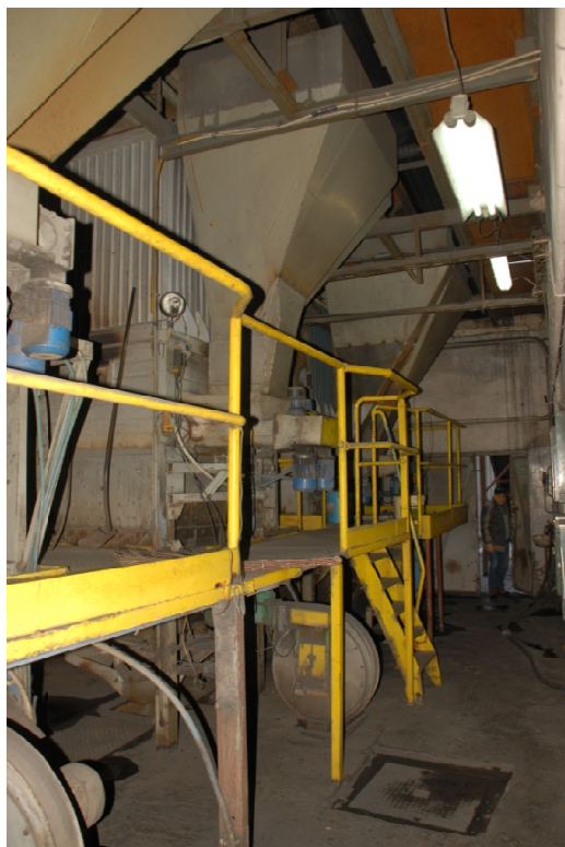
Rys. 3. Kotły przeznaczone do demontażu.
