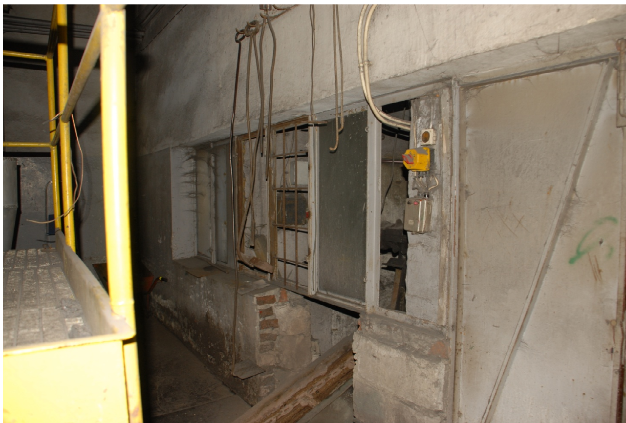
Rys.4. Elementy stolarki okiennej i drzwiowej przeznaczone do likwidacji.
